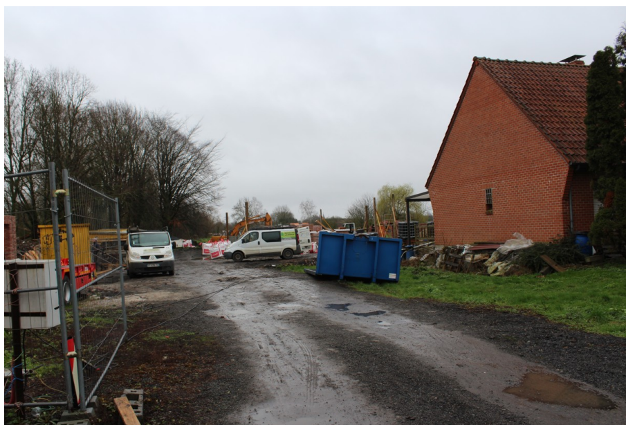
Vue des constructions en cours
